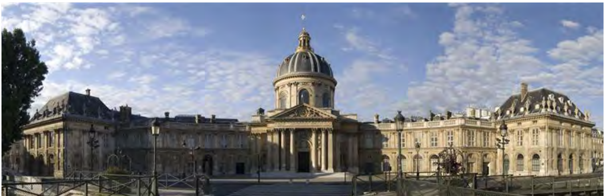
Façade de l'Institut de France (C) RMN-Grand Palais (Institut de France) / Gérard Blot
